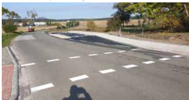
Autobusový záliv Stránka - Stavební část před předáním
