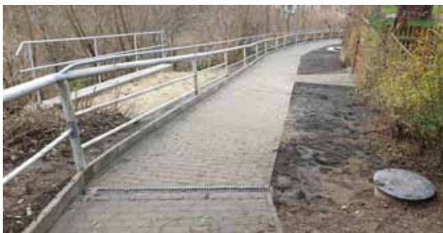
Dešťová kanalizace Stránka - Stavba před předáním
