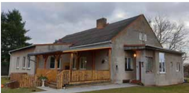
PŘED ZAHÁJENÍM NÁSTAVBY A PŘÍSTAVBY MŠ
