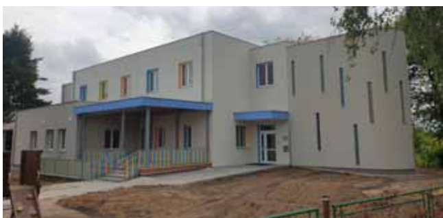
DOKONČENÍ STAVEBNÍCH PRACÍ
